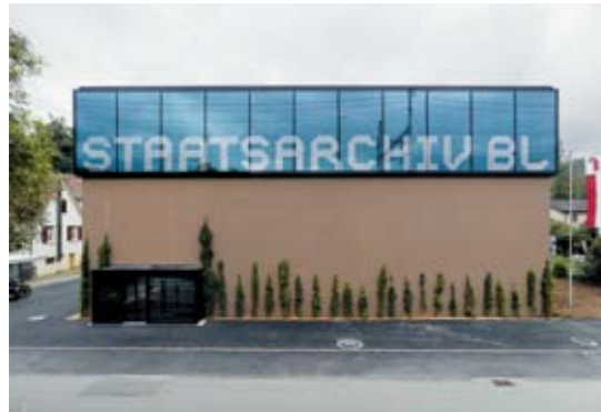
^3_ Der öffentlich zugängliche Teil des Staatsarchivs ist im zweiten Stock untergebracht. Foto: Hannes Henz
